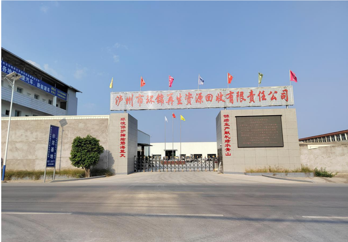
图 1 项目区主要出入口现状照片
