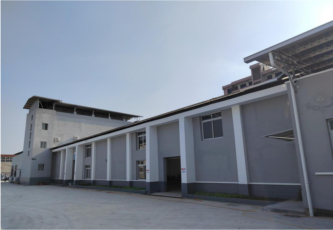
图3 建构筑物工程区（原泸州印染二厂既有建筑及硬化地面）现状照片
