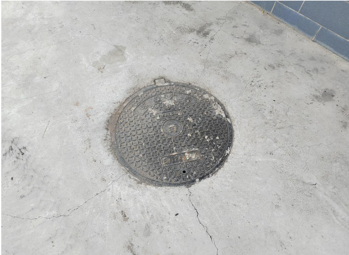
图 11 排水措施（雨水检查井）现状照片
