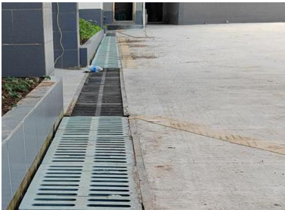
图9 排水措施（排水沟）现状照片
