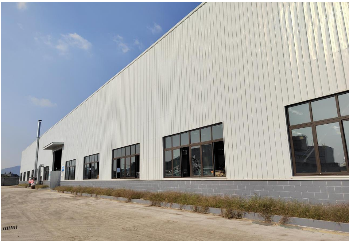
图 2 建构筑物工程区现状照片（新建）
