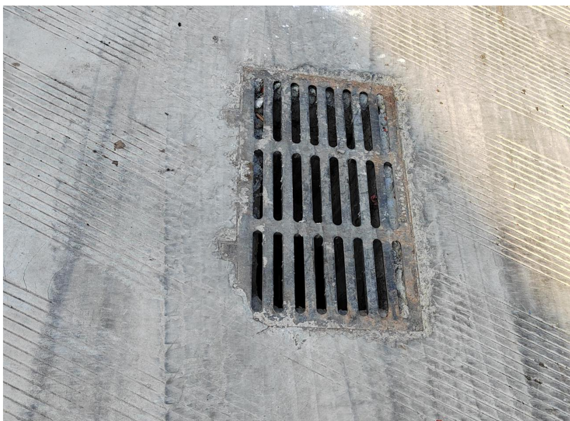
图10 排水措施（雨水口）现状照片
