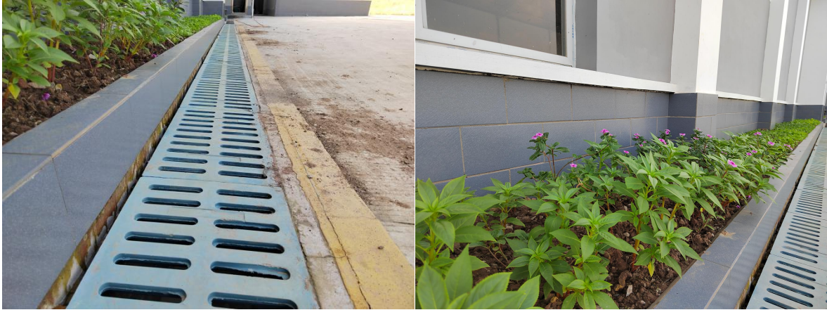
排水沟现状照片
